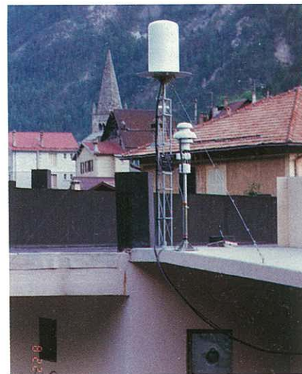
Station de référence. Reference station. St Etienne de Tinée (France).
